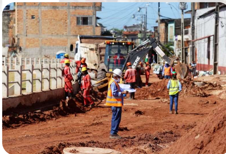
Obras de engenharia
